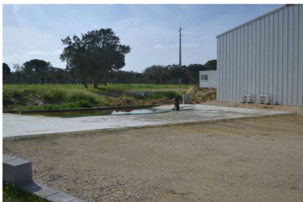
Foto 1 - Área de lavagem de máquinas. (fevereiro de 2020).
